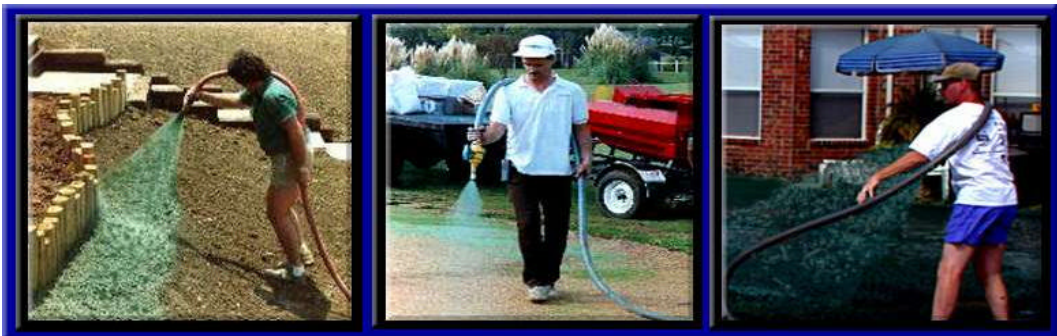
圖 4-27.噴植公司專門人員進行噴植( http://www.finncorp.com/index.asp )
